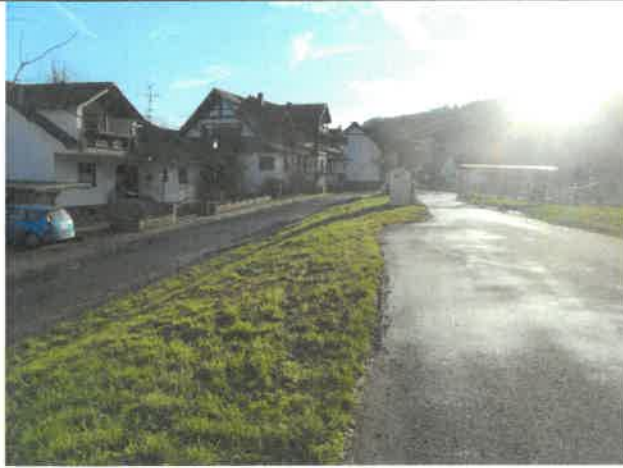
Pflanzung von 4-5 Alleebäumen an der gemeinde-eigenen Böschung
