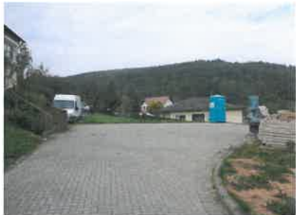
Blick in den Wendehammer der privaten Erschließungsstraße
