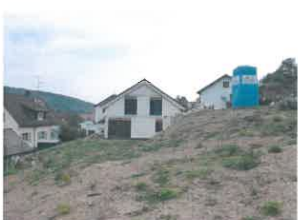
Neubau Knosbergstraße auf Flurstück 248/1, Blick von Nordwest
