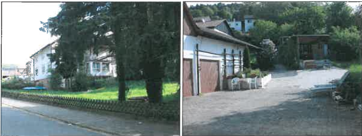
Blick von der Talstraße nach Norden auf das Wohnhaus Blick nach Osten in den Hof mit Garagen und Freisitz
