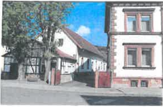
Hausnr. 33, Hauptgebäude und Zufahrt zum Hof
