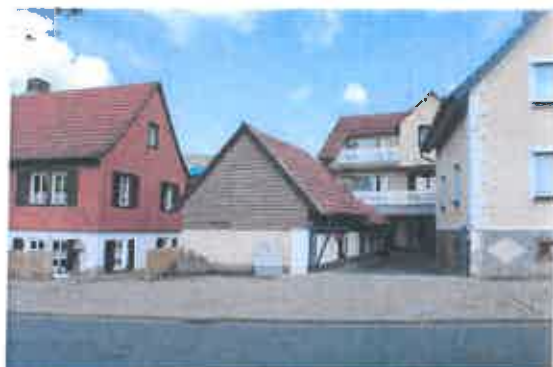
Rückwärtige Bebauung Haus Nr. 17
