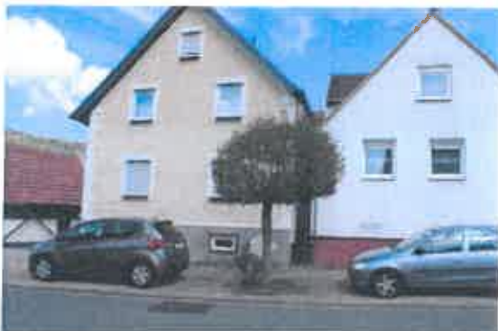
Brandgasse zwischen Haus Nr. 15 und 17
