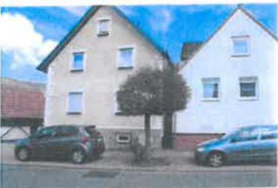
Brandgasse zwischen Haus Nr. 15 und 17
