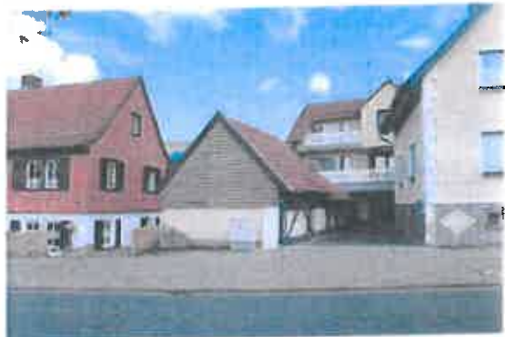
Rückwärtige Bebauung Haus Nr. 17
