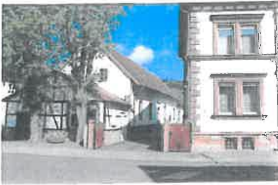
Hausnr. 33, Hauptgebäude und Zufahrt zum Hof
