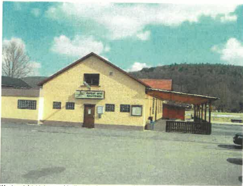
Westansicht Mehrzweckhalle Mümling Grumbach
